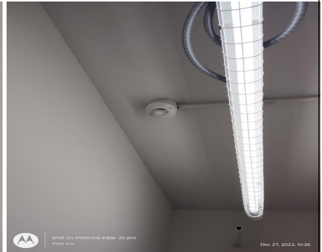
รูปที่ 2.5.7-12 อุปกรณ์ตรวจจับความร้อน (Heat Detector)
