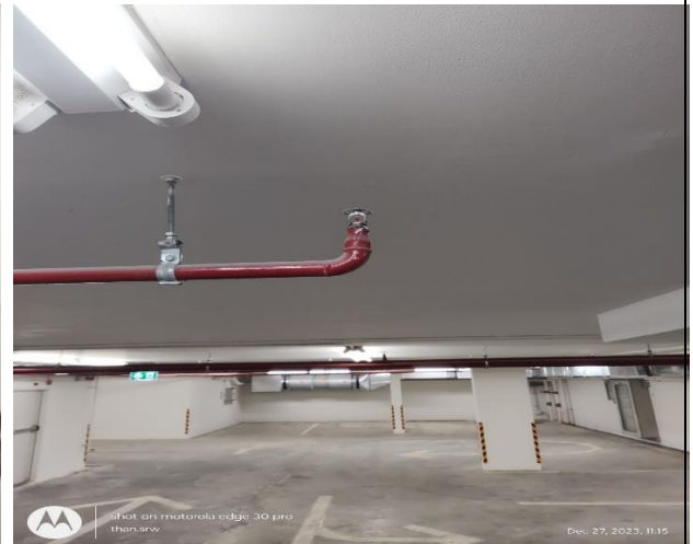
รูปที่ 2.5.7-5 หัวสปริงเกอร์ที่ชั้นใต้ดิน
