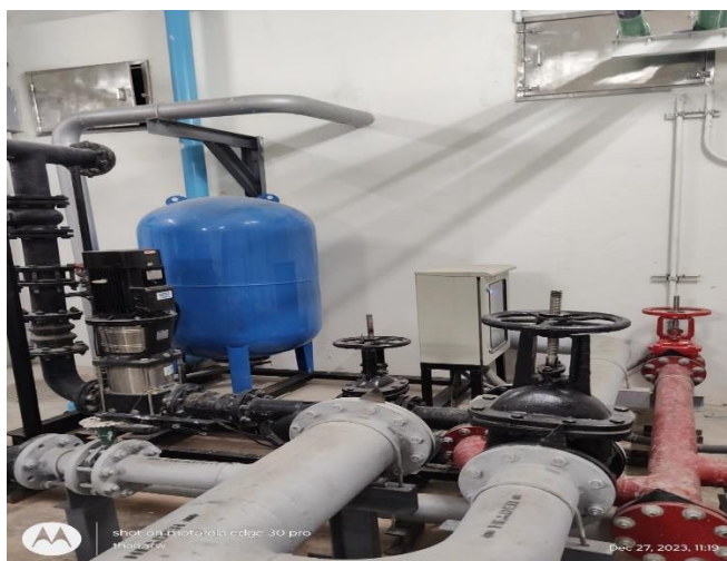
รูปที่ 2.5.7-6 บูสเตอร์ปั๊มระบบดับเพลิง
